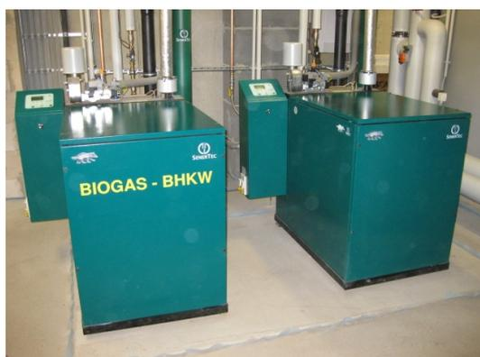
Biogas-BHKW und Erdgas-BHKW in der Heizzentrale „Openhouse“, Dorothea-Gartmann-Str. 1a - 3.
