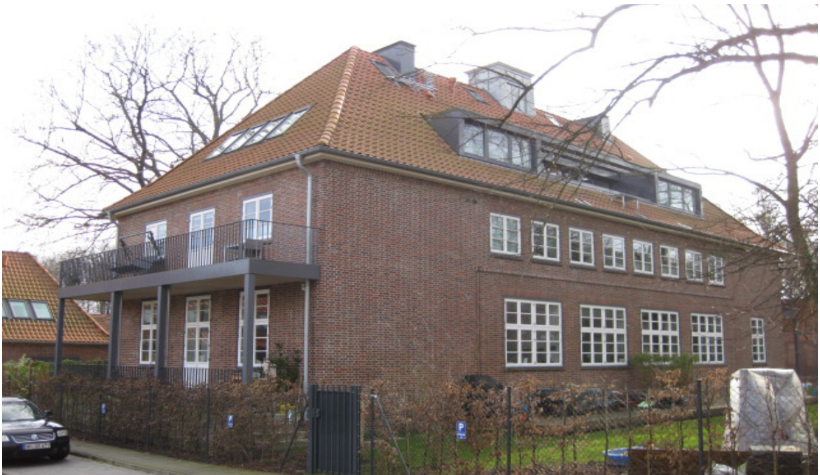
Holstenkamp: Gebäude mit der Heizzentrale
